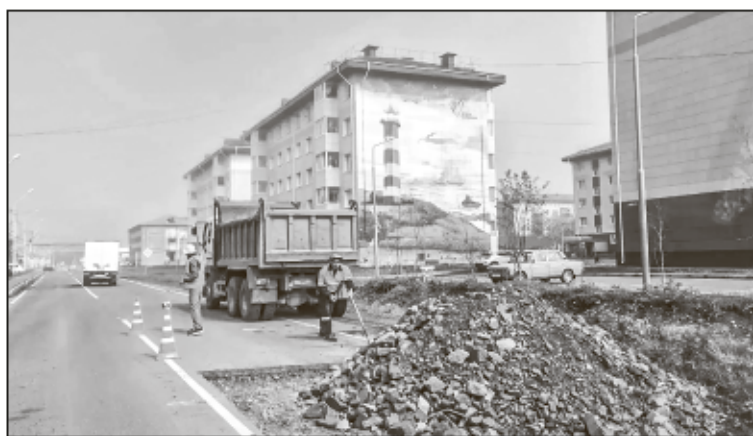
В Поронайске на улице 40 лет ВЛКСМ специалисты демонтировали старый асфальт, чтобы положить новый. / ПРЕСС-СЛУЖБА АДМИНИСТРАЦИИ ПОРОНАЙСКОГО РАЙОНА
